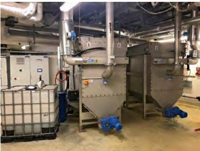
Abb. 2: Externer Wärmetauscher im Behälter (Foto: IBS, eigene Abbildung, Haus der Geschichte Regensburg)
