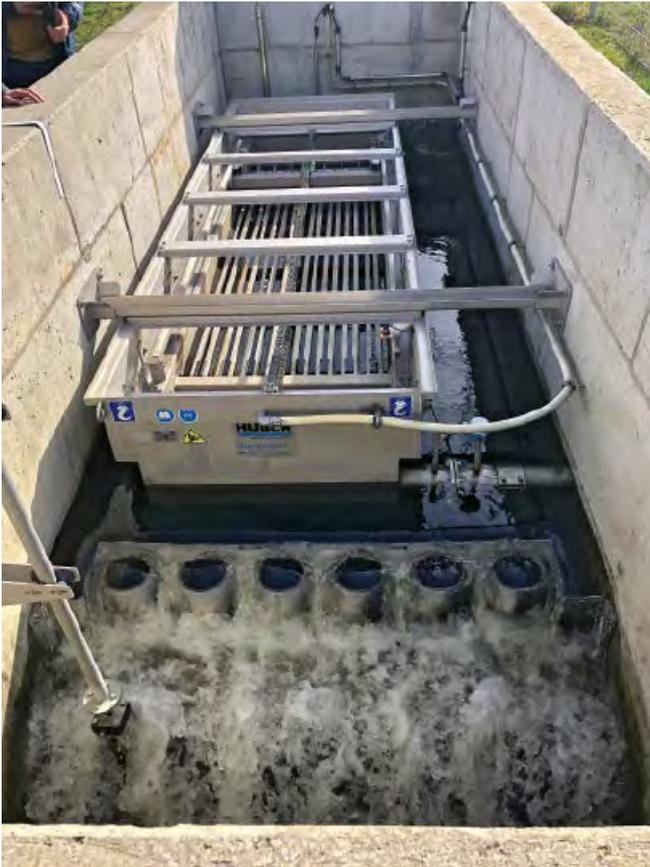
Abb. 1: Wärmetauscher im Gerinne zum Vorfluter (Foto: IBS, eigene Abbildung, Kläranlage Ingolstadt)
