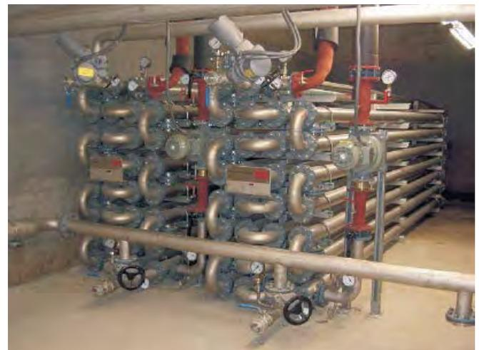
Abb. 3: Externer Rohrbündel-Wärmetauscher (Foto: B. Kobel, Rysler Ingenieure AG, Bern, entnommen aus [8])
