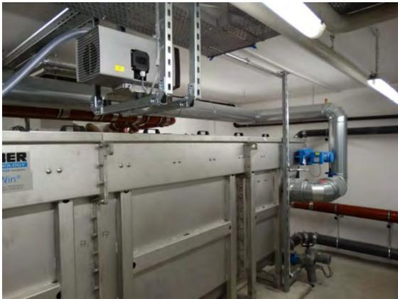
Abbildung 20: Externer Wärmetauscher im Behälter. Quelle: IBS.
