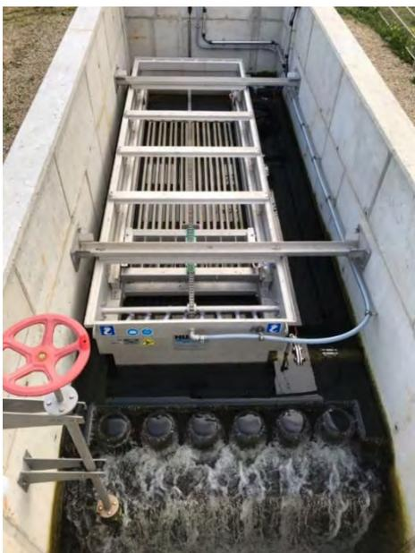
Abbildung 19: Wärmetauscher im Gerinne zum Vorfluter. Quelle: Huber.
